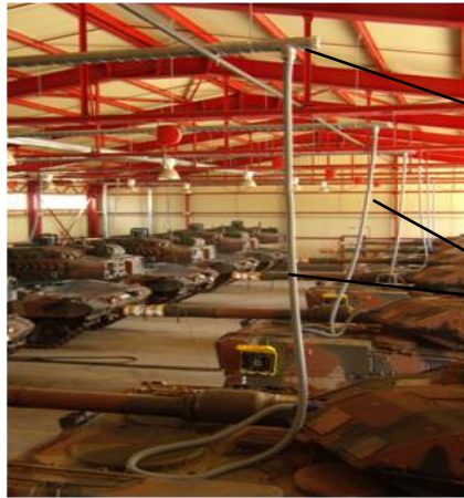
Εικόνα 3: Γενική άποψη δικτύου αεραγωγών προσαγωγής αέρα, εντός όρχου.
